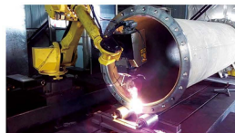
油井用管道激光修复
